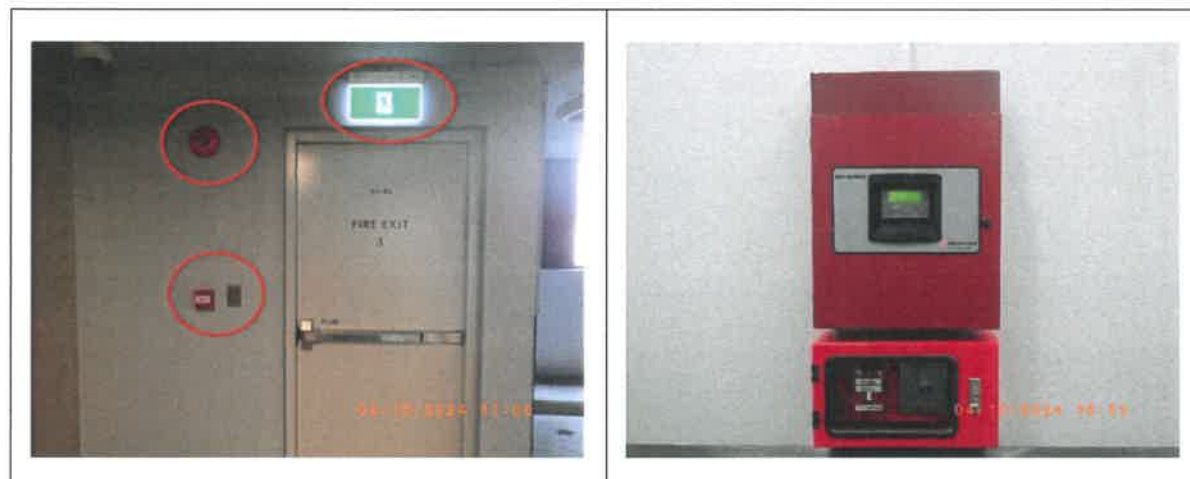
รูปที่ 56 ระบบเตือนอัคคีภัย (Fire Alarm, Smoke Detector, Heat/Detector, Alarm Bell, Fire Alarm Manual)
