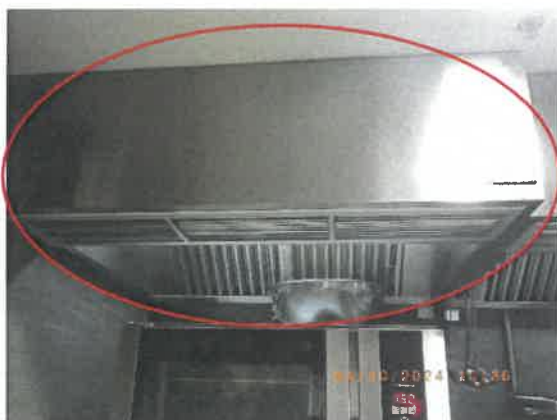
รูปที่ 34 ติดตั้งพัดลมดูดควันที่ห้องครัว
