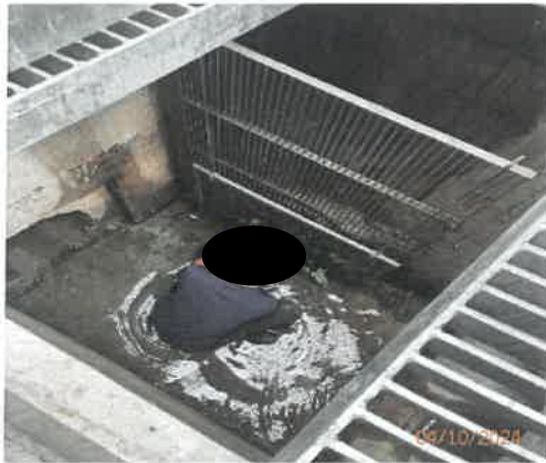
รูปที่ 32 การตรวจสอบดูแลบ่อกักของระบบระบายน้ำ
