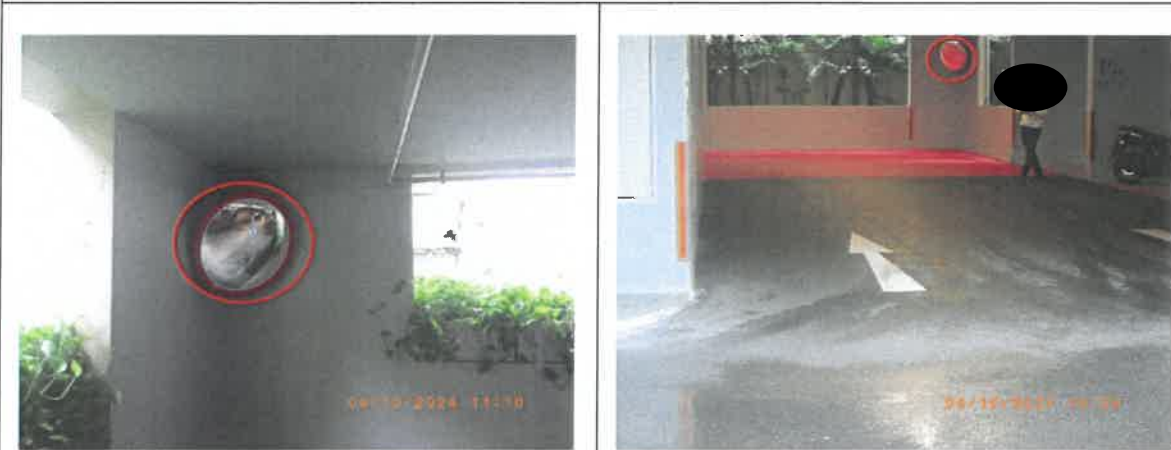
รูปที่ 10 ติดตั้งกระจากโค้งจราจร
