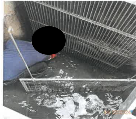
รูปที่ 32 การตรวจสอบดูแลบ่อกักของระบบระบายน้ำ
